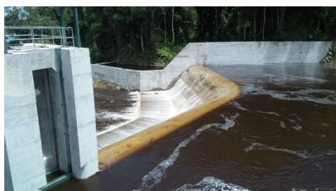
堰止めエリア
