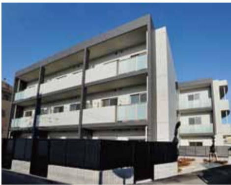
トヨ一建設が建設した建物の一例
