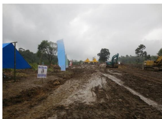
周辺のインフラ工事中
