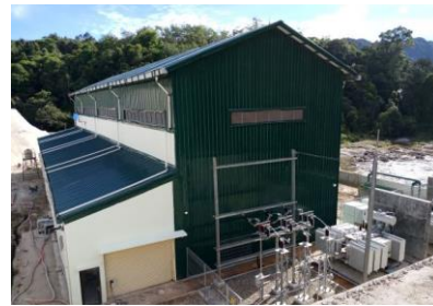
発電機室の外観
