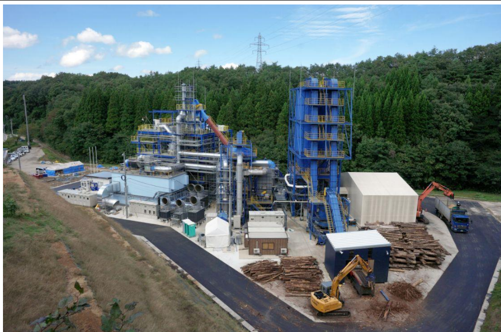
完成写真（左：輪島バイオマス発電所、右：チップ工場）
